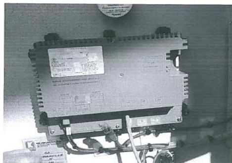
**Рис. 1** Изображение Панели сенсорной Siemens HMI 8"
